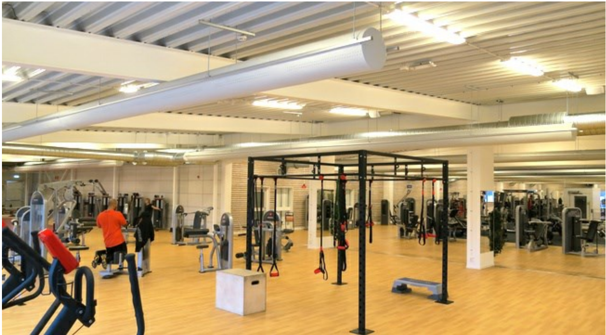
Gymmet är utrustat med \varnothing 315 injektdon med dubbla skenor för variabelt flöde. Klicka för fler bilder
